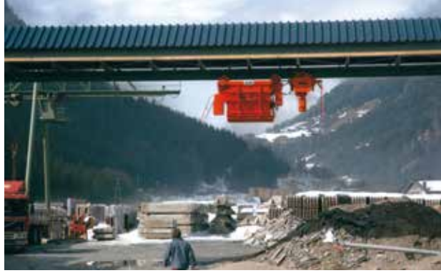
Klappenkübel in Brücke 30 m
