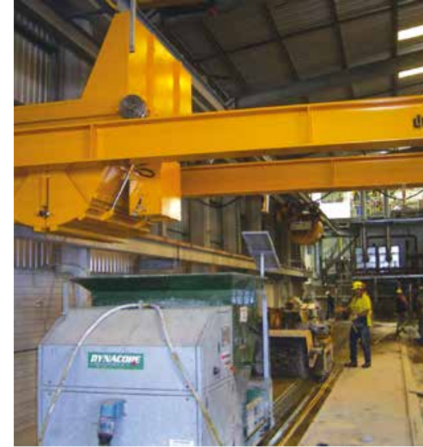
Automatische Nachfahrt zum Fertiger
