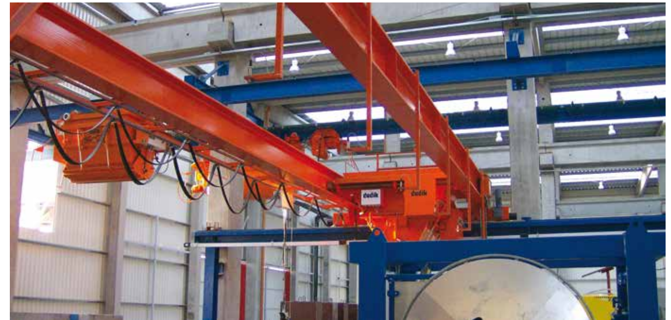
Automatische Nachfahrt Kübelbahn zum Betonverteiler - Betonverteiler zum Extruder
